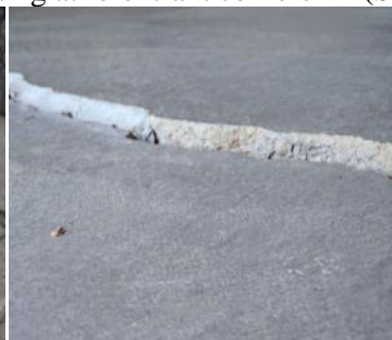
(d) Settling Concrete Cracks
