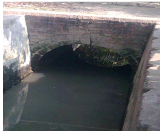
(d) Drain at 1 no. Custom Ghat
