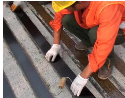
(d) CFRP strip placed on the epoxy glue.
